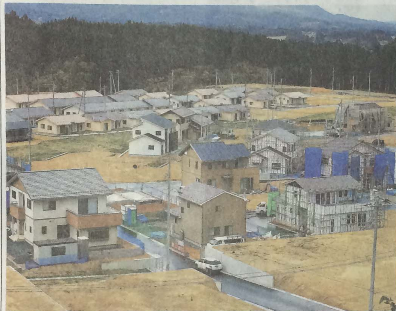
市は造成工事を加速させ、2016年3月末までに全体の98・4%に当たる46地区で造成工事を完了させる見通し。
